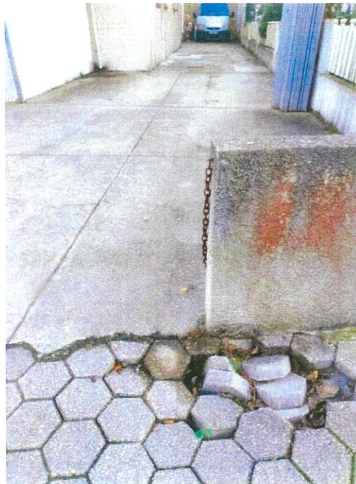
Trabalho de recuperação de Passeio
